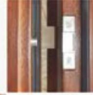
Einbruchssperre von der Seite der Scharniere
